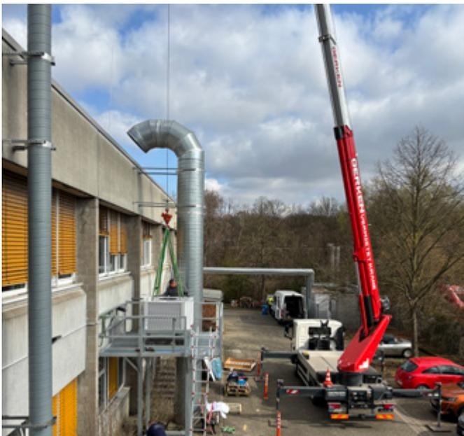
Mit Hilfe eines Krans wurde die Kühleinheit auf das Stahlgerüst aufgesetzt.
